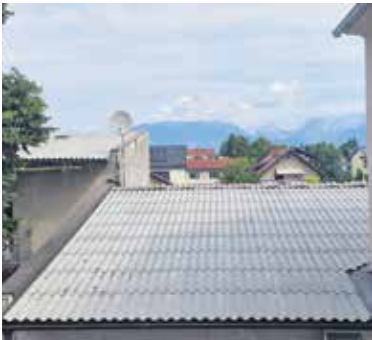
Obnova strehe na domu krajevnih skupnosti na Ljubljanski 58 v Domžalah
