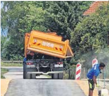
Obnova nivojskega železniškega prehoda v Depali vasi
