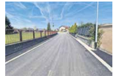
Zaključena je obnova ceste Mala Loka-Bišče. Foto: Občina Domžale
