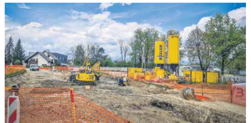
Gradnja zadrževalnika deževnih voda v Mačkovcih. Foto: Karin Božič Zupančič
