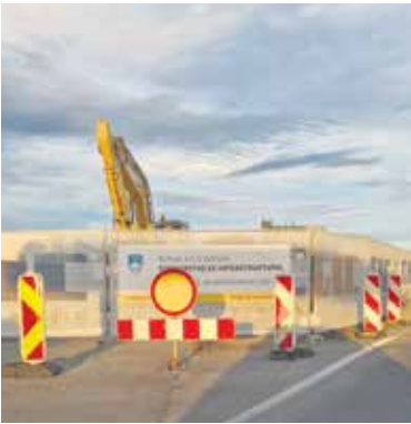
Promet preko Kamniške Bistrice bo še vedno potekal po montažnih mostovih z občasnimi zaporami.
