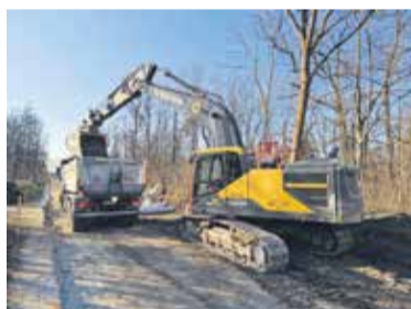
Rekonstrukcija ceste v Bišče
