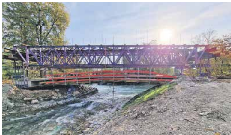
FOTO: OBČINA DOMŽALE Rekonstrukcija brvi čez razbremenilnik Pšata Jarše–Mengeš
