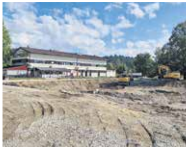
Na gradbišču priljubljenega domžalskega kopališča
