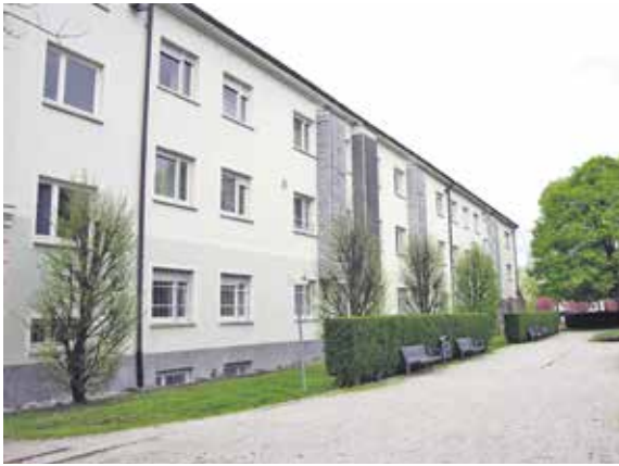
Stavba Občine Domžale s strani parka
