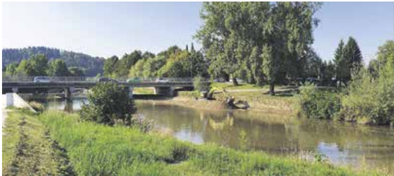
Nadaljujejo se sanacijska dela gorvodno.
