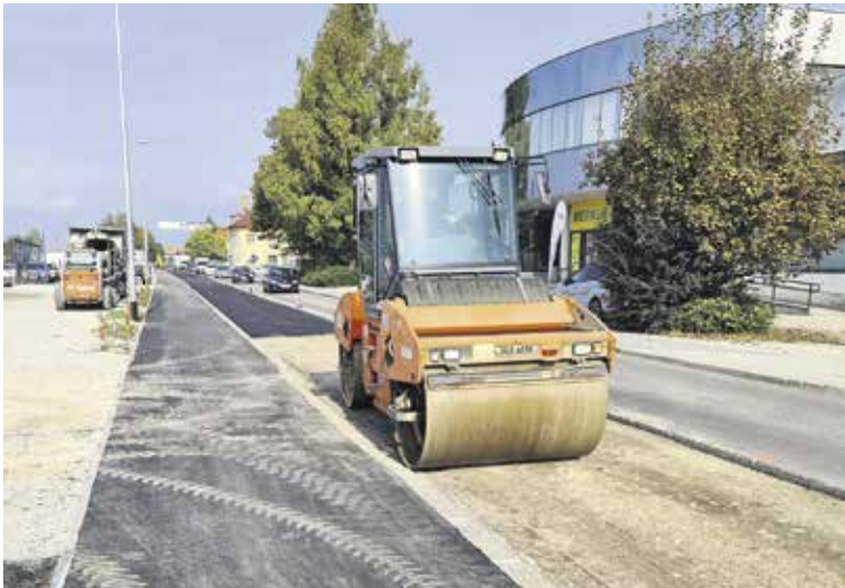
Prenovljeno vozišče in nov pločnik na Kamniški cesti
