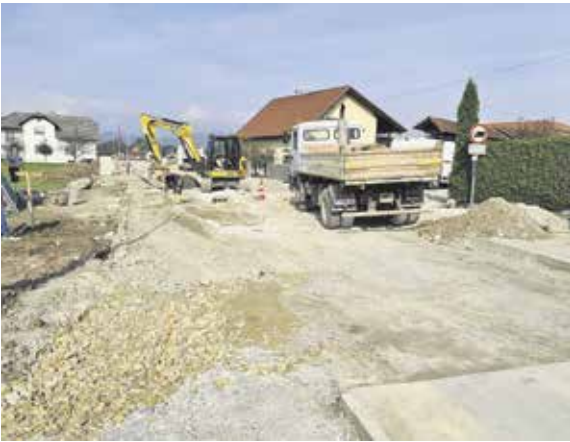
Nadaljujemo s 1. fazo prenove ceste Dob–Češenik–Turnše
