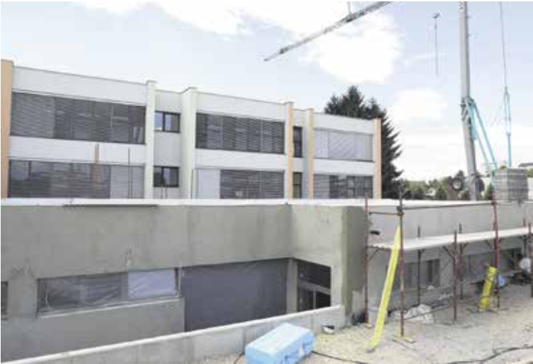
Gradnja novega pločnika na Škrjančevem
