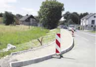
Dela na pločniku v naselju Dragomelj
