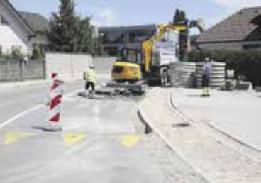
Gradnja novega pločnika na Škrjančevem
