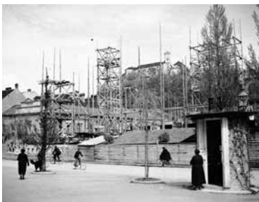
Začetek gradnje NUK leta 1937
