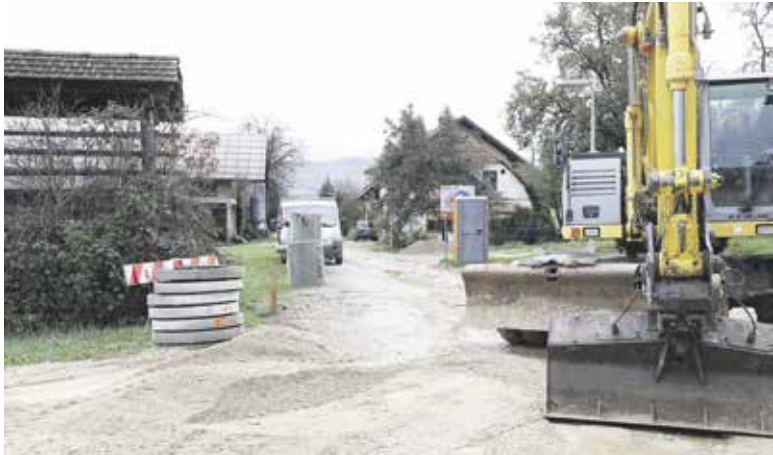
Kanalizacija in vodovod Brezje pri Dobu; trenutno potekajo dela na hišnih priključkih in gradnji TK omrežja (investitor Telekom), asfaltiranje je predvideno do konca novembra.
