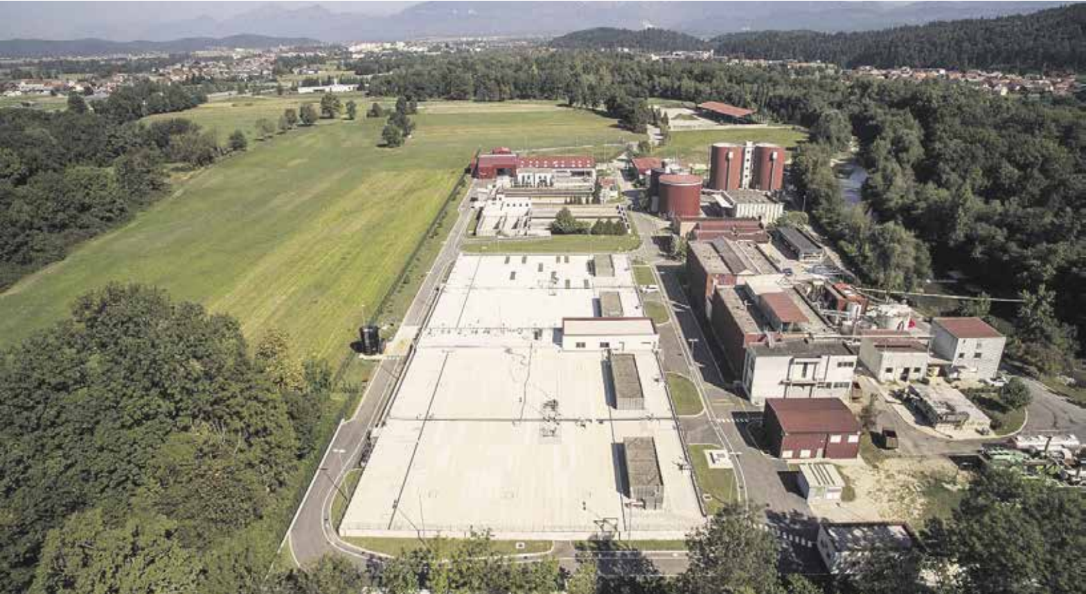
Centralna čistilna naprava Domžale - Kamnik po nadgradnji 2016
