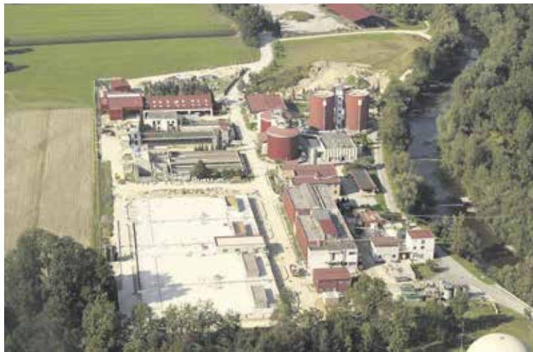
Nadgrajeni sistem CCN vključuje tri glavne procesne sklope: nov vstopni objekt, novo aerobno biološko stopnjo in obstoječo anaerobno biološko stopnjo.
