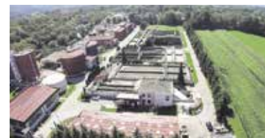
CCN pred začetkom nadgradnje v letu 2013.
