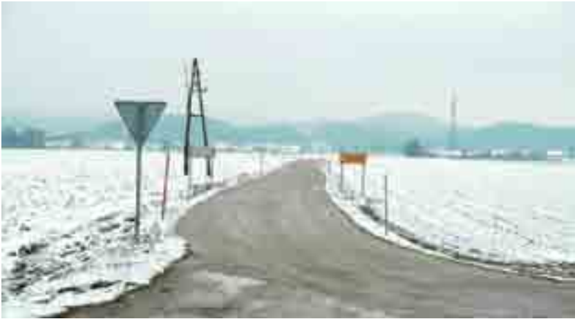
V pričakovanju asfaltiranja ceste Dob–Črnelo
